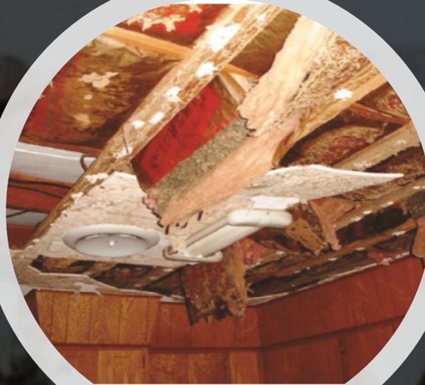
...ion d'un plafond
